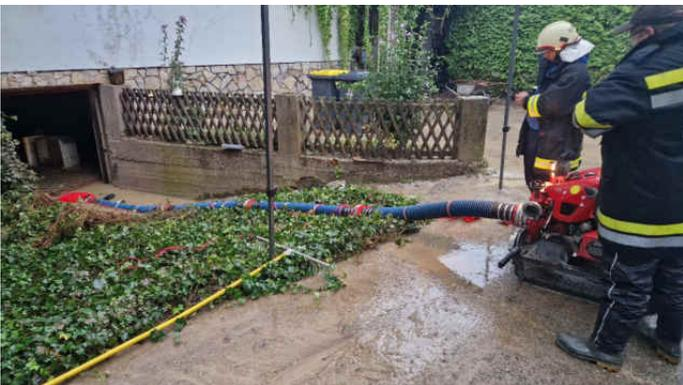
Für das Auspumpen der Keller wurden sowohl Tauchpumpen, als auch Tragkraftspritzen benötigt.
